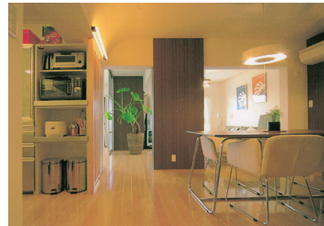
②撤去できない耐力壁・梁をデザインに取り込む。
