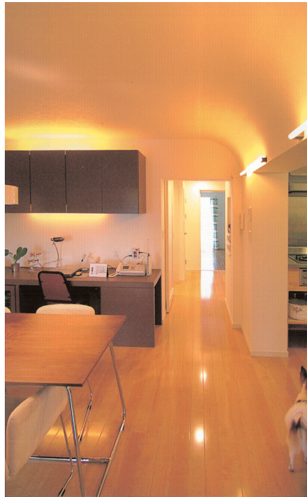
①窮屈なRC壁構造の制約の中で創った新しい空間。ダウンライトが入らない低い天井には家具を用いて間接照明を。低すぎる梁の圧迫感を和らげるためにR天井とリネストラ照明を。
